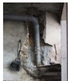
^ détail d'e.p. dans le mur en pisé
