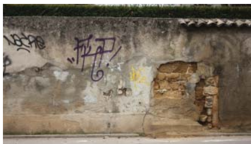
^ Mur de clôture du 44 rue de la Favorite. D.A., 2011
